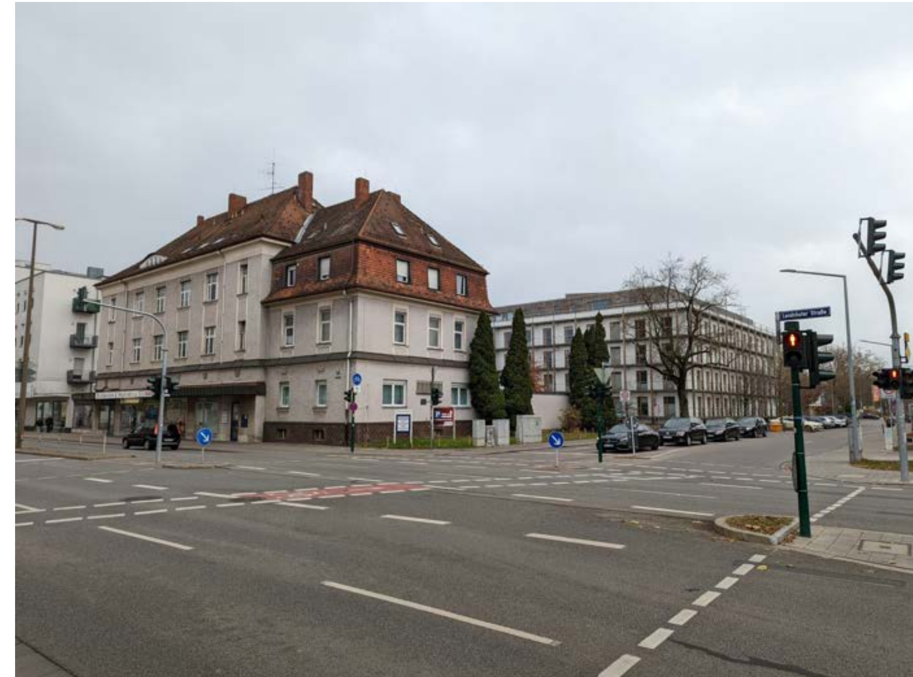
Abb. 17: Ein noch erhaltenes Gebäude der Kavalleriekaserne heute
